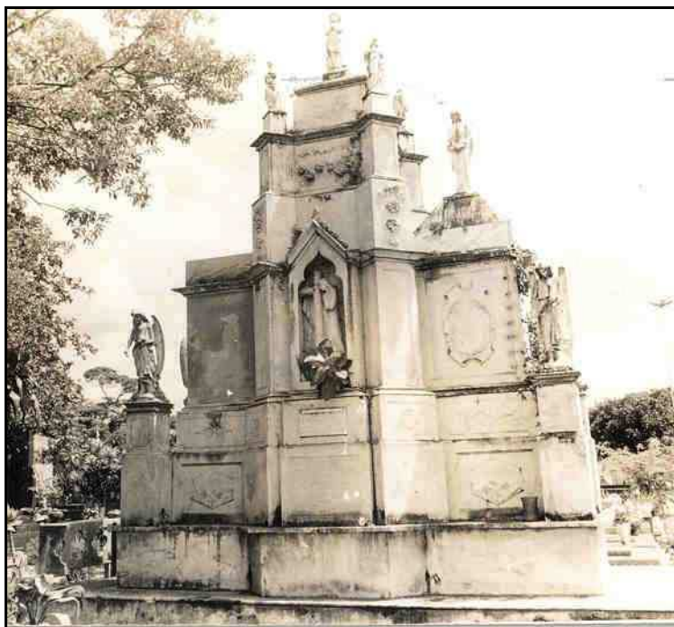
Figura 2. Monumento funerário de la Família Alves Ferreira (1898-1906), revestido de losas de márml de Carrara. Cemitério da Saudade, Ribeirão Preto (SP). Fonte: foto de César Mulati.
